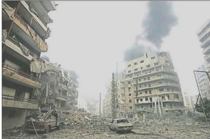
Рисунк 20: Приклад MDZ-подібного вибухового пошкодження
